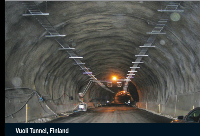
Vuoli Tunnel, Finland
