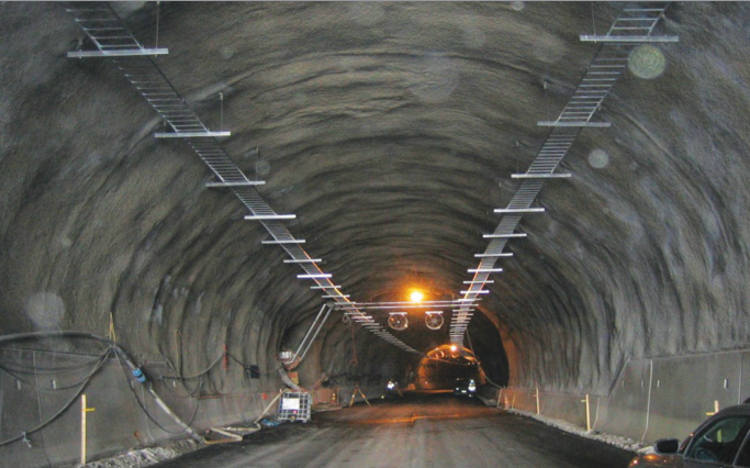
Vuoli Tunnel, Finland
