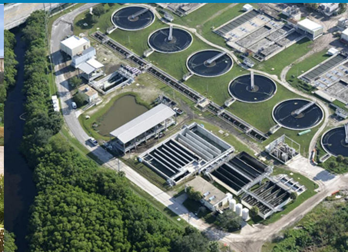
Megamix II with Bio-San: Impianto di Depurazione Largo - USA
